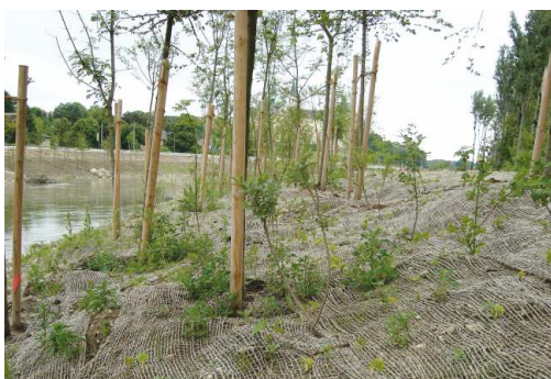
Geotessili - Sifor ® di juta posata trasversalmente rispetto al terreno.
