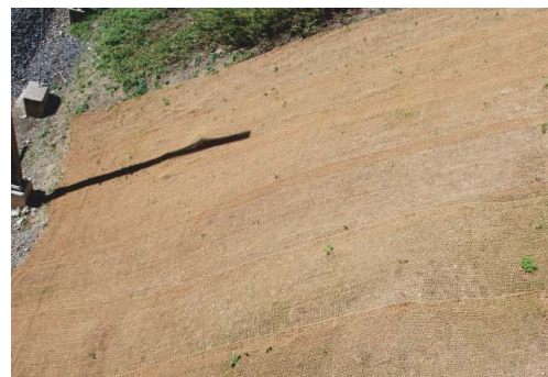
Geotessili - Sifor ® di cocco appena posata.
